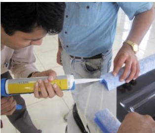
1.1 Vorbereiten der Dichtung
